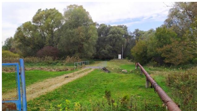
szennyvízátelő a patak túloldalán
