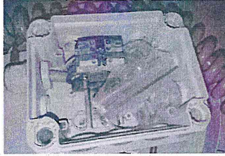
20. Szekrény 230V-os betáplálás bekötésére szolgáló kötődoboz
