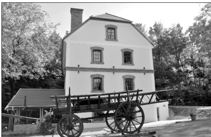
A falazat több helyen cserére került, speciális anyagokat is felhasználva. A tetőszerkezet teljesen új faanyagból készült, a korábbi tetőszerkezet méretei alapján legyártva.
